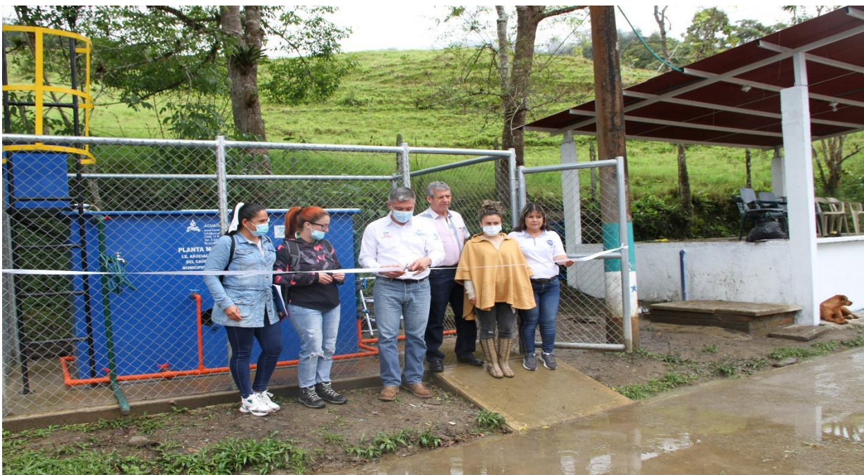
Foto Vallecaucana de Aguas / Ptap Vereda La Hondura- Dovio - Valle del Cauca
